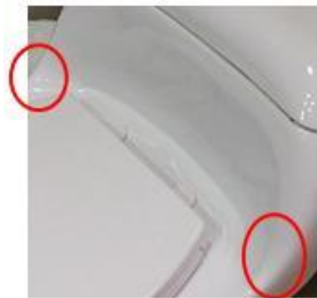
水箱前兩端凸出無法安裝
